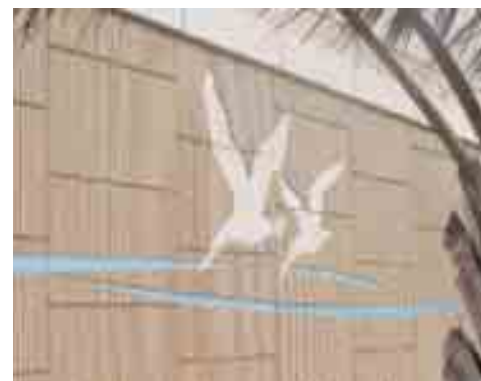
Pour les murs de soutènement, "nous développons des parements qui permettent une vraie expression architectonique".
