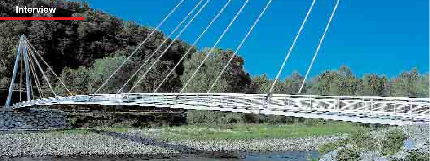
Les câbles en fibres de carbone, mis en œuvre sur la passerelle de Laroin en France, contribuent à améliorer la durabilité des structures.
