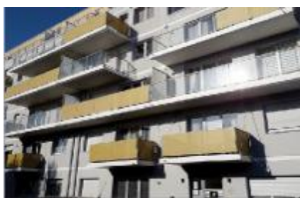
Réparation de suspentes métalliques (La Bassée - 59)
