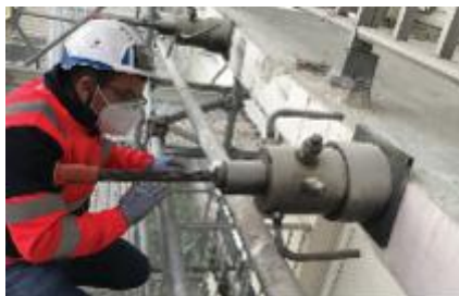
Réparation de balcons par précontrainte (Limeil-Brévannes - 91)
