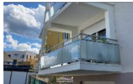
Etalement et ajout de consoles béton (Thonon - 74)
