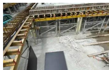
95 – Marcouville – Démolition reconstruction d'un parking après incendie
