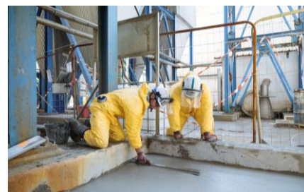
Réparation et reconstitution d'une dalle avec application d'une résine de protection adaptée. Venator, Comines (59)
