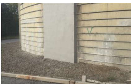
Précontrainte additionnelle de réservoir circulaire. DSP, Chauny (02)
