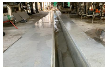
Reconstruction des caniveaux et du dallage, avec résine adaptée en zone acide. Saipol, Le Meriot (10)
