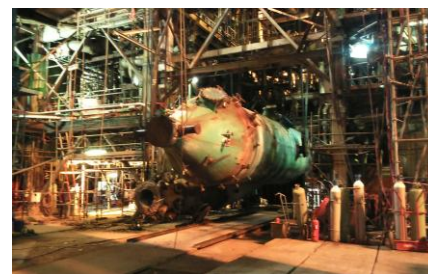
Descente et levage d'un stripper Exxon ND de Gravenchon (76)
