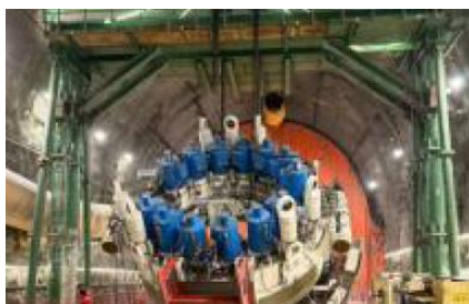
Assemblage en caverne du tunnelier Tunnel Lyon-Turin
