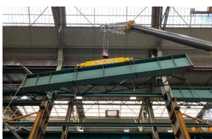
Etalements d'urgence Usine Framatome LE CREUSOT (71)
