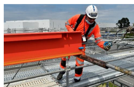
Changement de voies de roulement USINE AIRBUS (44)
