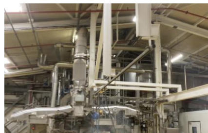
Renforcement de charpente ROYAL CANIN – AIMARGUES (30)
